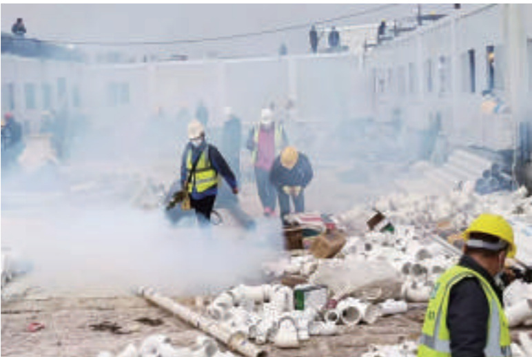
▲2月6日，队员们携带防疫装备和物资进入武汉雷神山医院建设现场，启动防疫消杀行动。同时，对建设方人员开展了防疫消杀培训。(红基)
